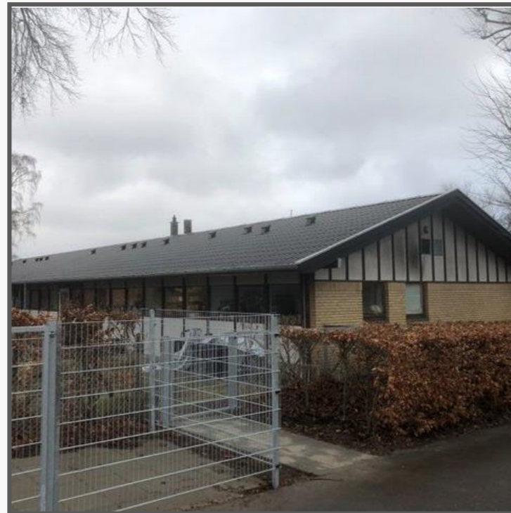
Børnehuset Prinsessehøj Udskiftning af eternittag på I.H. Mundtsvej 2C
