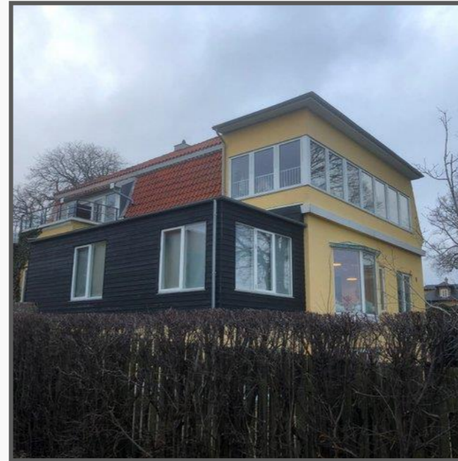
Taarbæk Børnehus Renovering af vinduer og døre, understrykning af tegltag
