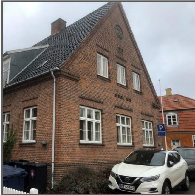
Bondebyens Børnehave Renovering af vinduer og døre
