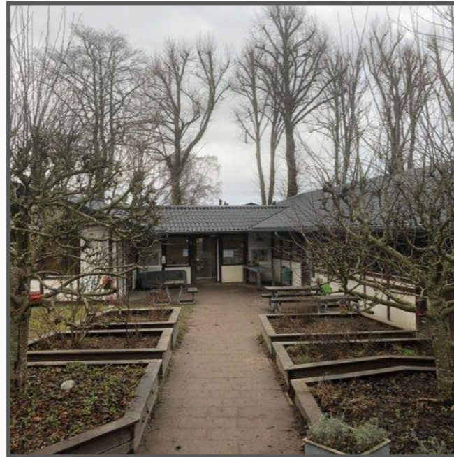
Børnehuset Prinsessehøj Udskiftning af eternittag på I.H. Mundtsvej 2A
